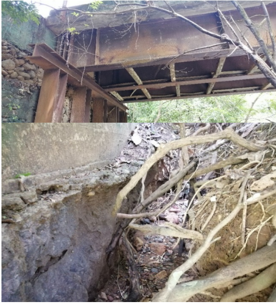
Imagen 7. Puente de estructura mixta
