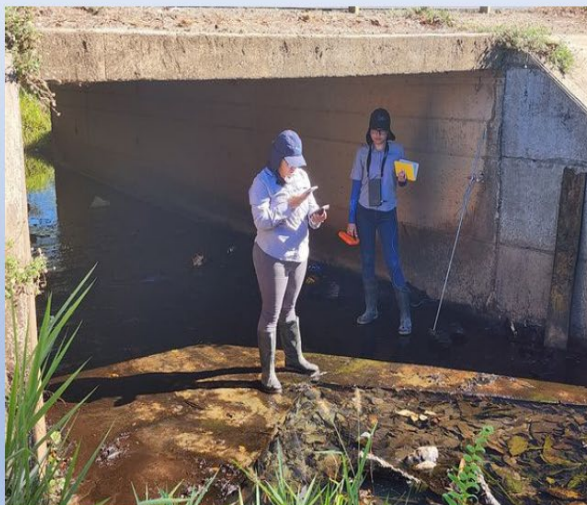
Inspección de SETENA
